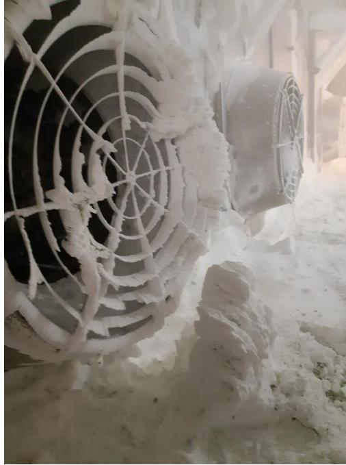
Figure 9 : Accumulation de givre devant un ventilateur en aval des batteries soufflées par des tirs d'air comprimé
